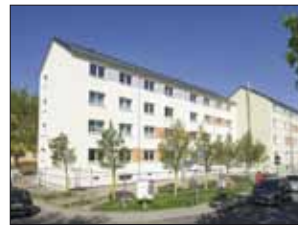
Hochheimer Straße 22-24 Salzburger Straße 17-19
