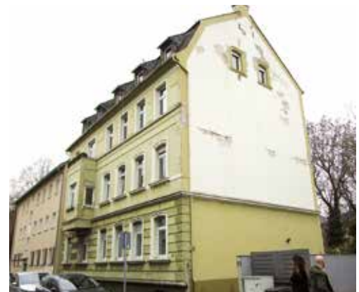
Vorher: Karl-Lehr-Straße 21, Straßenansicht
