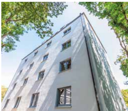
Nachher: neue Fassade, neue Fenster
