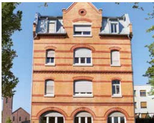
Nachher: renovierte Fassade
