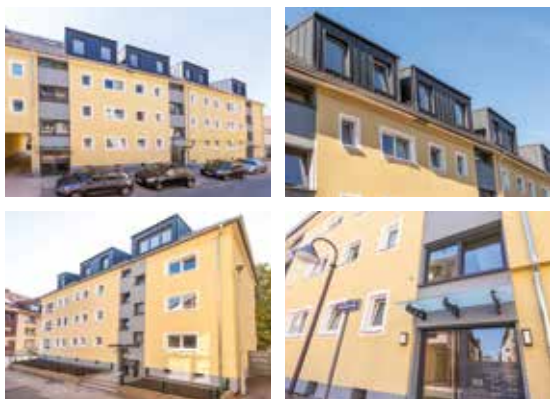
Nachher: neuer Eingangsbereich, neue Fenster, neue Gauben, neuer Vorplatz Zehnthofstraße
