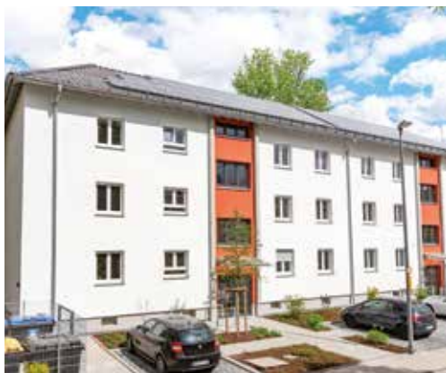
Nachher: gedämmte Fassade, neue Hauseingänge, neue Photovoltaikanlage
