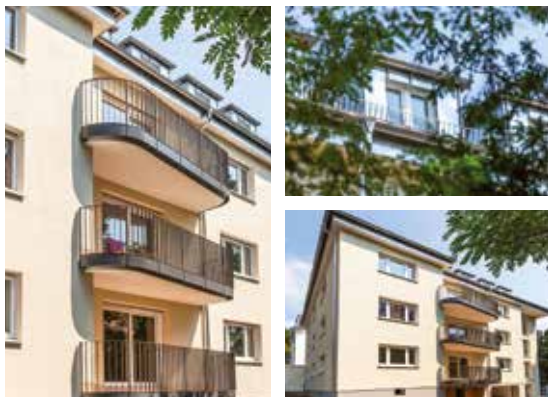
Nachher: sanierte Balkone, sanierte Gauben
