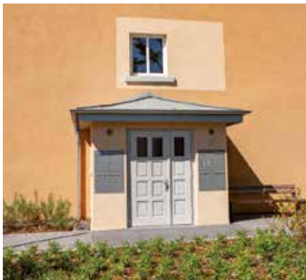
Nachher: renoviertes Dach, renovierter Hauseingang
