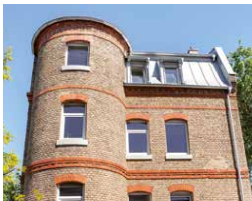
Nachher: renovierte Fassade
