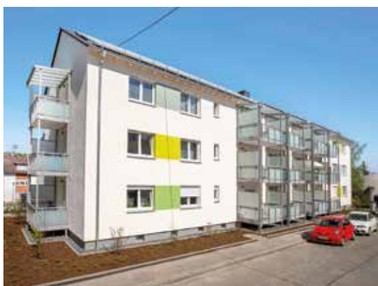
Nachher: Bestandsbalkone, neue Hauseingänge, neue Photovoltaikanlage
