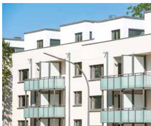
Nachher: neue Vorstellbalkone und Hauseingänge, Aufstockung: neue Appartements mit Terrassen
