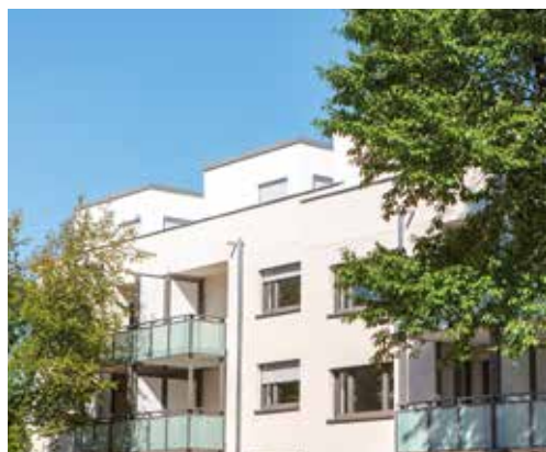
Nachher: gedämmte Fassade, neue Fenster
