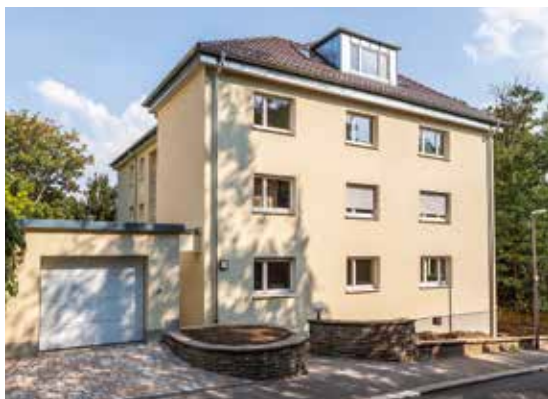
Nachher: neue Fassade, neuer Eingangsbereich, neuer Fenster, neue Gauben, neuer Vorplatz
