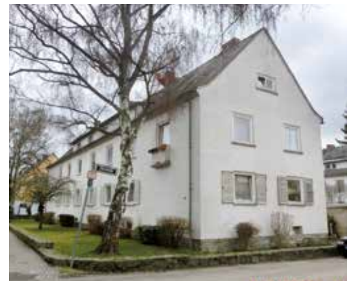
Vorher: Wiesenstraße 8-10, Straßenansicht
