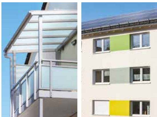
Nachher: 15 neue Vorstellbalkone, gedämmte Fassade, isolierverglaste Fenster
