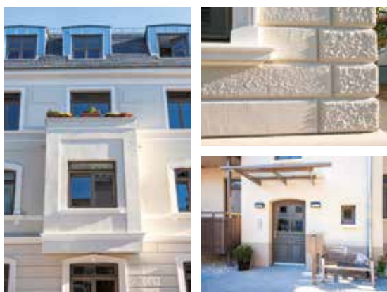
Nachher: isolierverglaste Fenster, liebevoll und detailliert: stilecht hergerichtete Fassade
