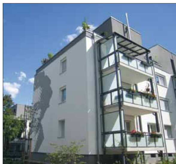
Setzt neue Gestaltungsmaßstäbe: Die Sanierung der Häuser in der Frauenlobstraße/ Wilhelm-Hauff-Straße.
