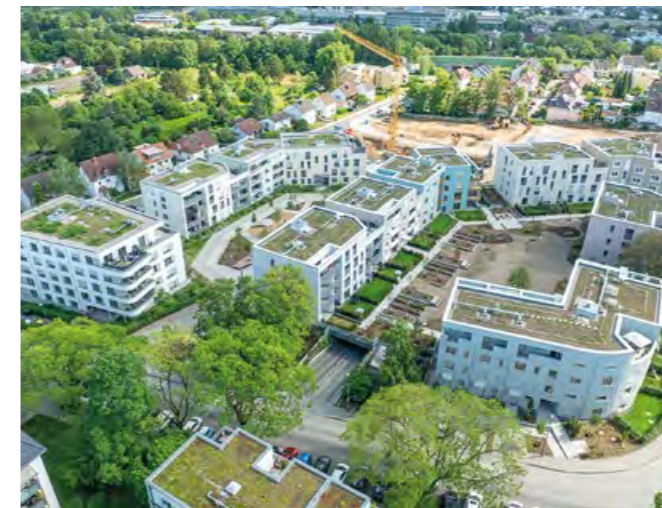
Der 2. BA im Schönau-Quartier ist fertiggestellt, die Erdarbeiten am 3. BA sind bereits gestartet
