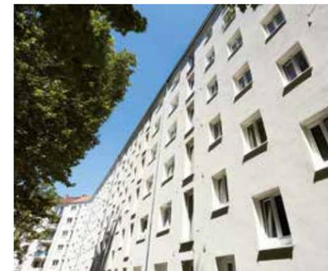
Nachher: gedämmte Fassade, isolierverglaste Fenster
