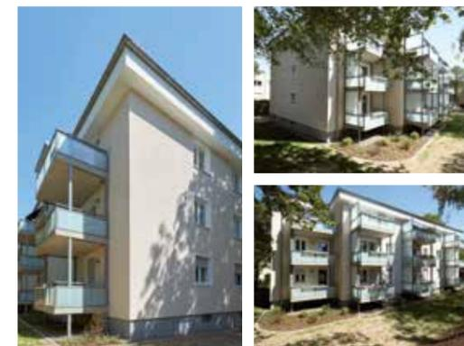
Nachher: gedämmte Fassade, neue Vorstellbalkone
