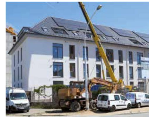
Nachher: gedämmte Fassade, isolierverglaste Fenster, neue Photovoltaikanlage, neuer, gedämmter Dachstuhl
