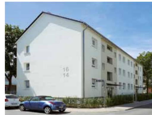
Nachher: gedämmte Fassade, isolierverglaste Fenster
