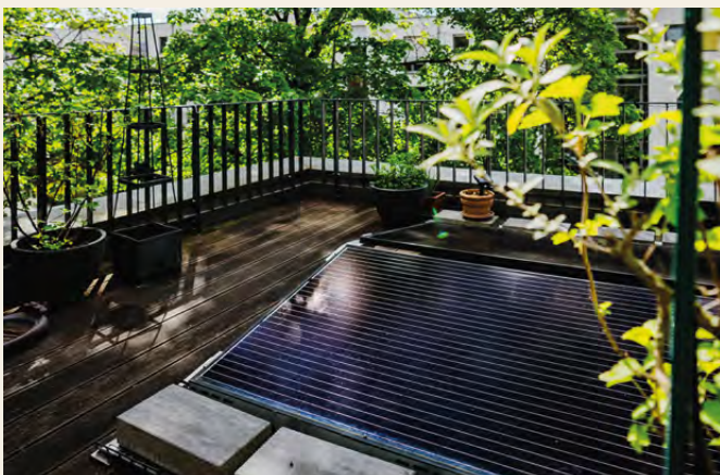
Die horizontal montierten Module nutzen fast ganztägig die Sonne
