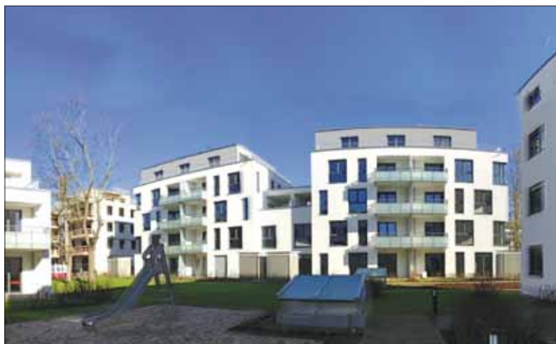
Im Weidenborn ist bald die Hälfte der 850 neu geplanten Wohnungen fertiggestellt. Foto: GWW
