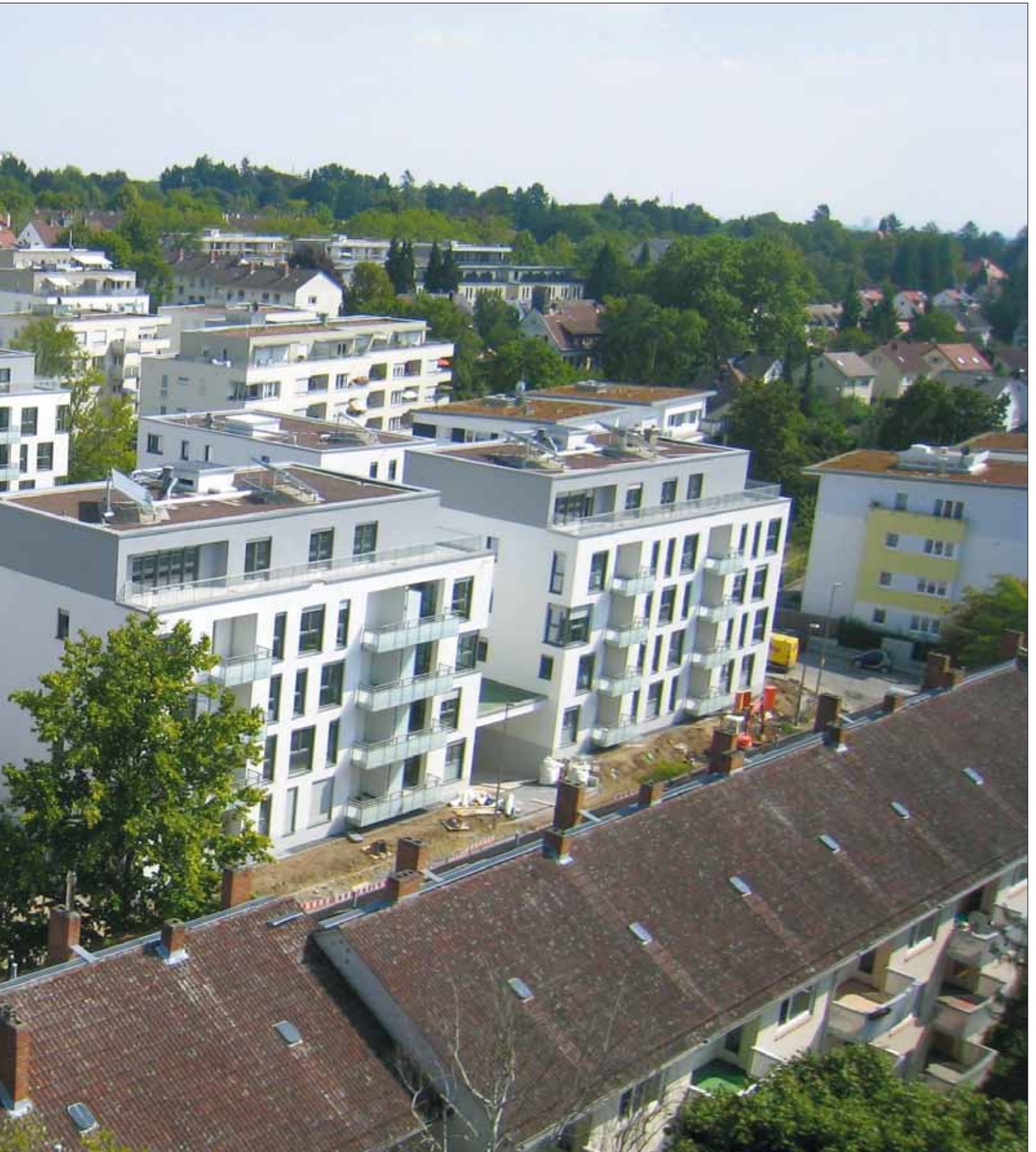
Im Weidenborn in Wiesbaden-Südost entsteht ein nachhaltiges Wohnquartier mit 850 Miet- und Eigentumswohnungen. 2012 war die Hälfte der neuen Wohnungen bereits fertiggestellt.
