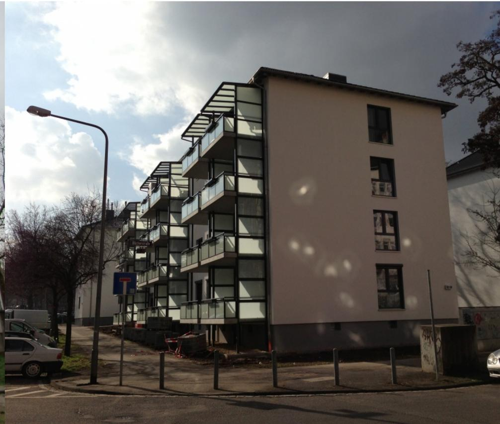
Die fünf bereits 1953 errichteten Wohnhäuser wurden umfassend energetisch saniert. Die um einen begrünten Innenhof angeordneten Gebäude wurden vom Keller bis zum Dach gedämmt und alle Fenster ausgetauscht. Mit 104 neuen Vorstellbalkonen verfügt nun jede Wohnung über ihren eigenen Balkon.
